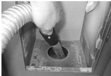
Fig. 31 - Czyszczenie komory rusztu paleniskowego
